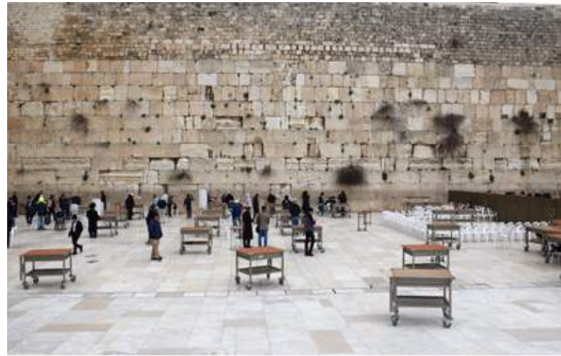
Resim 66b. Burak/Ağlama Duvarı (İYV Arşivi)
