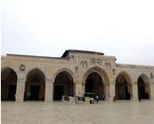
Kible (Aksa) Cami Kuzey Cephe
