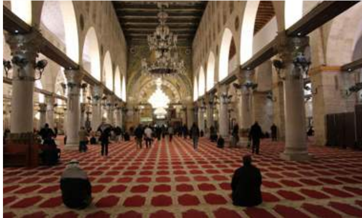
Resim 12. Mescid-i Aksâ'nın daha geniş olan orta sahnı. Sahnların sütunları arasındaki 1969 yangınından sonra yeniden yapılmış olan ahşap kaplamalı hatılların genel bir görünüşü (İVV arşivi)
