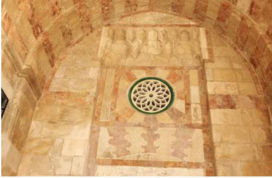
Mescid-i Aksa Eşrefiyye Medresesi Giriş Kuzey Penceresi
