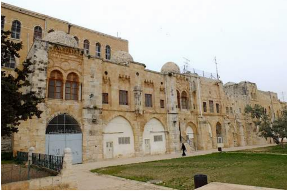
Re 55. 11 Mescid-i Aksa kuzey revakları üzerinde bulunan batıdan doğuya doğru sırasıyla Caviliyye, Melekiye, Esardiye, Farisiye, Emiriyye, Basitiye ve Dividdar Medreseleri (MT Arşivi)
