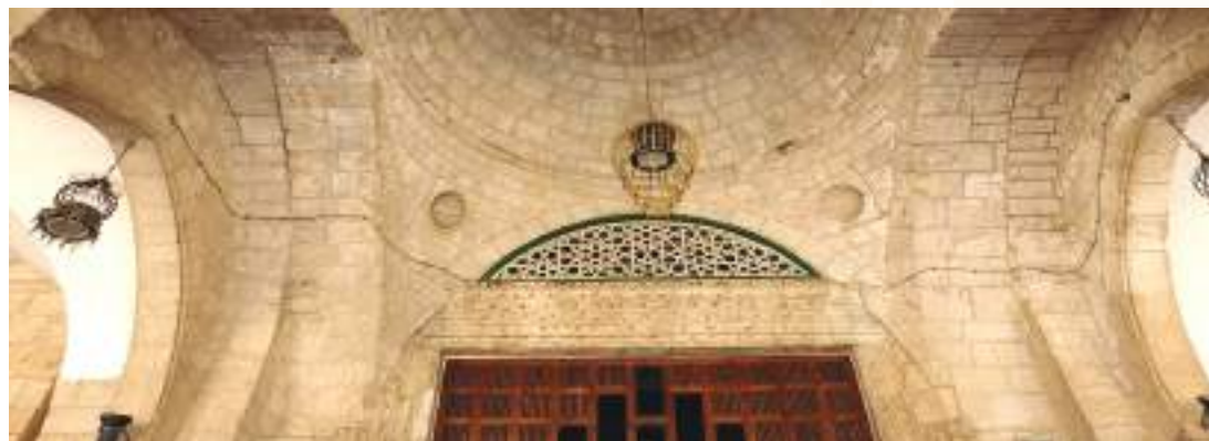
الباب والقبة- المدخل الرئيسي للواجهة الشمالية- الجامع القبلي
