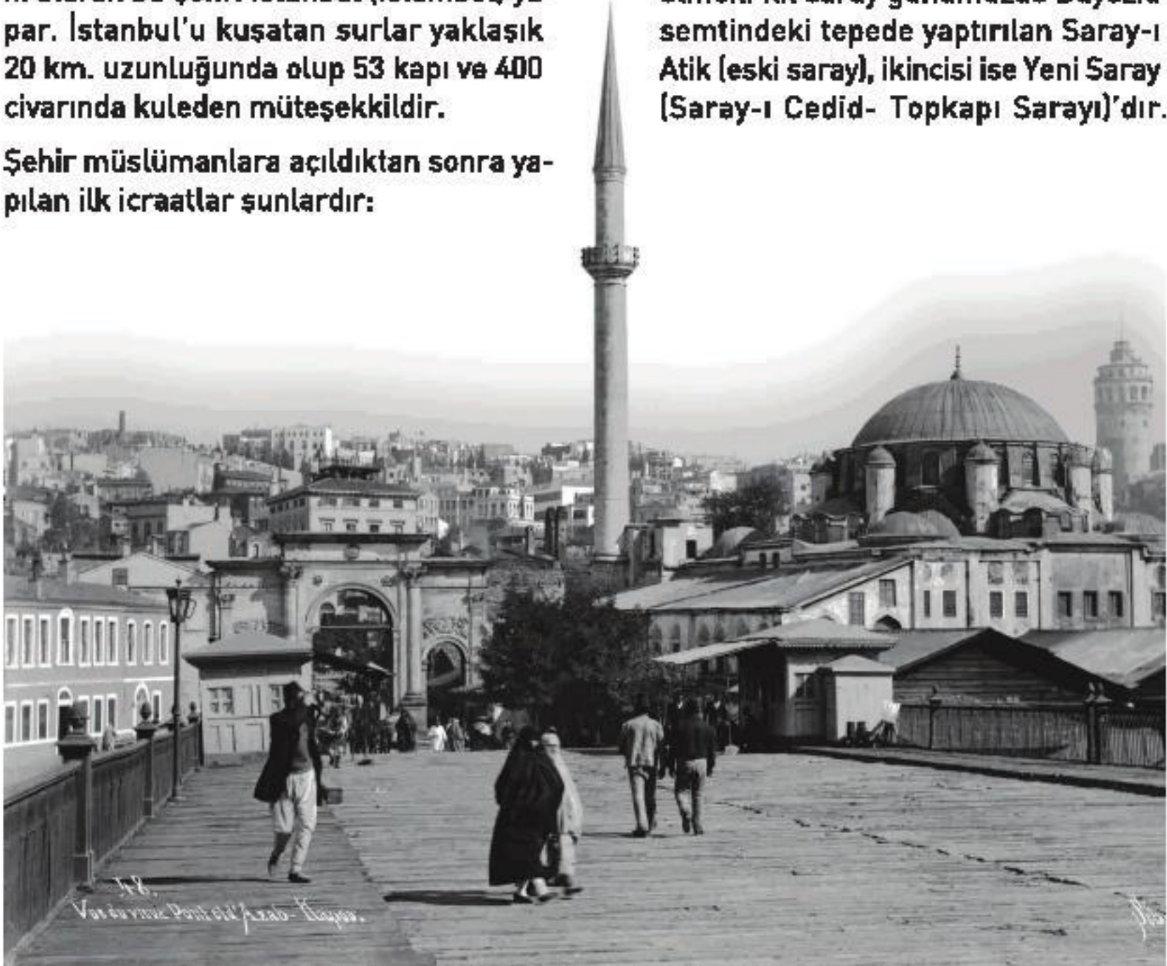
Bir zamanlar kullanılan tahta köprüden Azâp Kapı'daki Sokullu Mehmet Paşa Camii'ne bakış.
