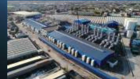
TAŞKENT B Doğal Gaz Kombine Çevrim Santrali 230 MW
