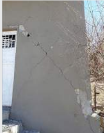
Şekil 8: Yetersiz derz boşluklarından dolayı oluşan hasarlar
