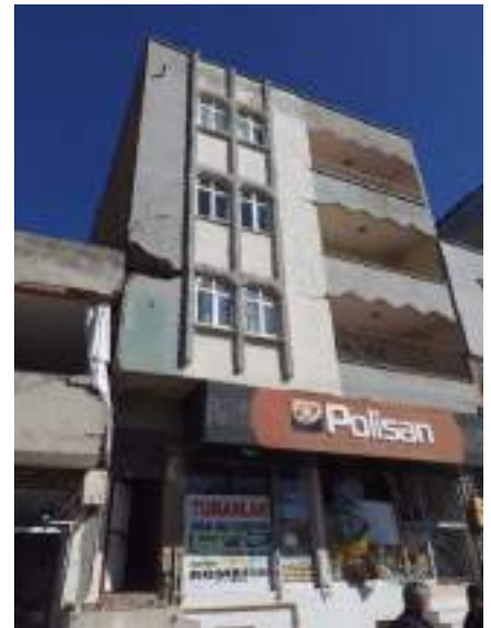
Şekil 8: Yetersiz derz boşluklarından dolayı oluşan hasarlar
