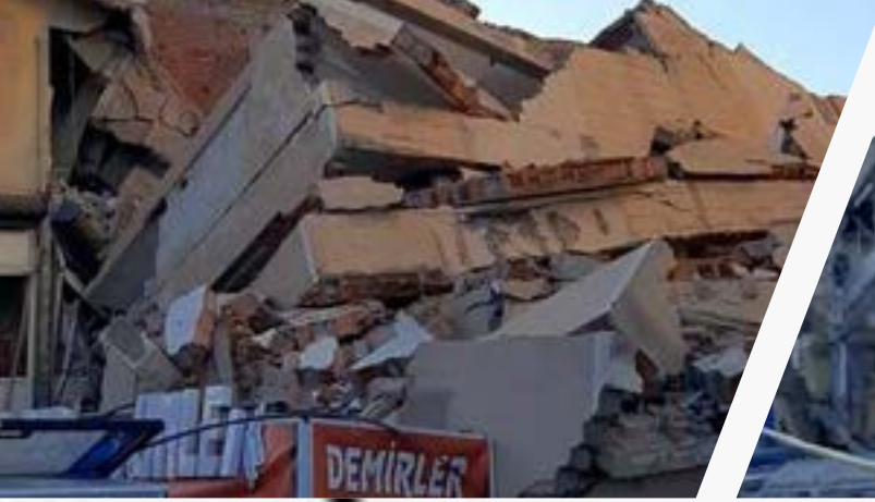
Şekil 12: İmalata yönelik hatalardan dolayı yıkılan binalar
