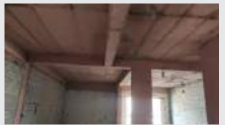
Şekil 10: Yumuşak kat düzensizliği (Giriş kat dükkanlar) ve Saplama Kiriş
