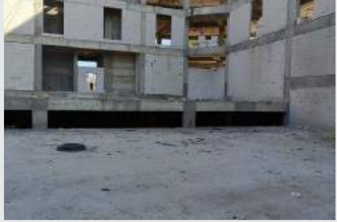
Şekil 5: Kısa kolon oluşumu
