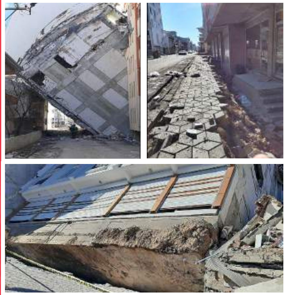
Şekil 3: Zemin Sıvılaşması ve Zeminde Oturma
